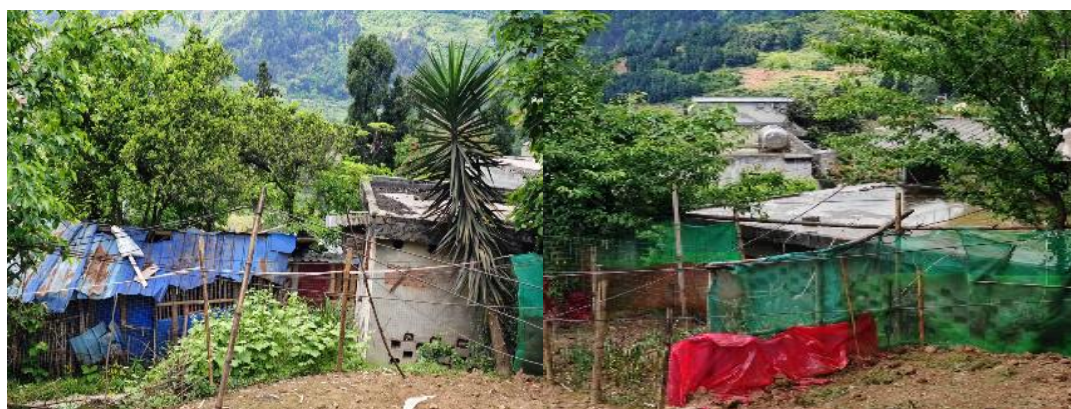
图 2-7：九天大道拟拆迁农村居民住宅房屋现状
