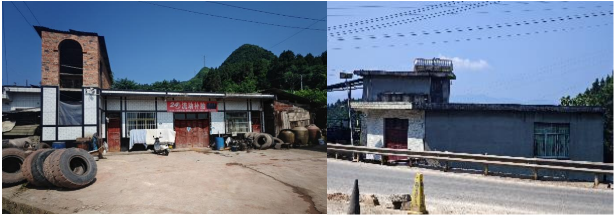
图 2-8：庙九西路拟拆迁农村居民住宅房屋现状
